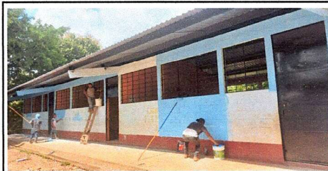
Foto 3: se observa pintura en muro exterior y interior
