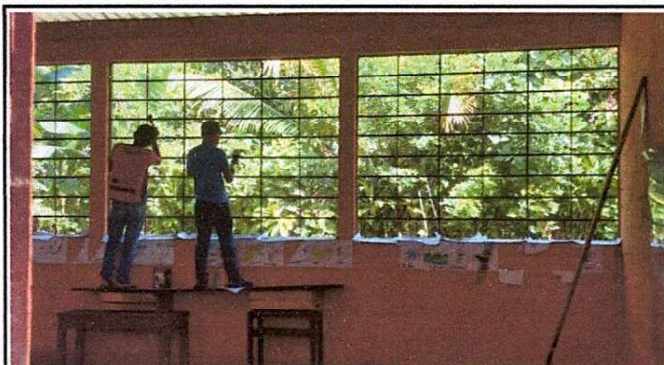
Foto 2: Se observa el mantenimiento de las ventanas de las tres aulas del modulo 1.
