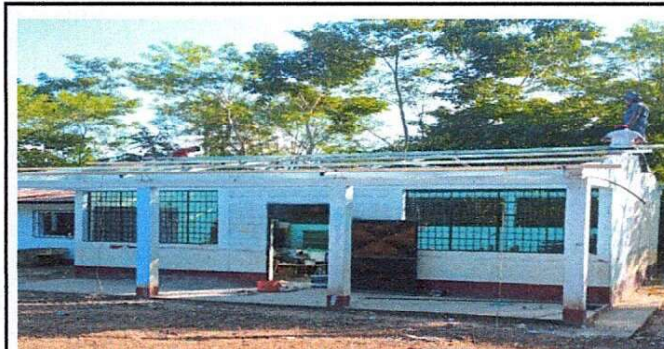
Foto 4: Se observa el cambio del techo de la dirección-bodega de la cual se cambio el reglón número 02 para la misma.
