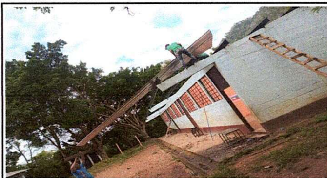
Foto1: Se observa el cambio de techo de lamina.
